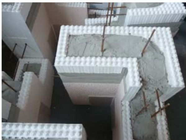
Рис. 1 Пример бетонирования с несъемной опалубкой
