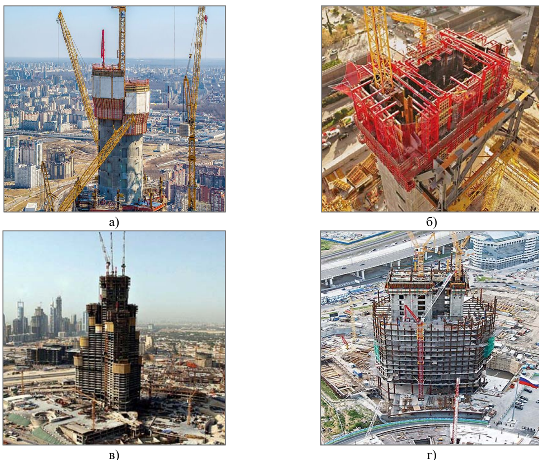
Рис. 1. Использование самоподъемных систем опалубки при возведении высотных зданий: а – Лахта-центр (г.Санкт-Петербург, Россия), б – Куатро-Торрес (г. Мадрид, Испания), в – Бурдж-Халифа (г.Дубай, ОАЭ), г – Башня Евразия (г. Москва, Россия).
